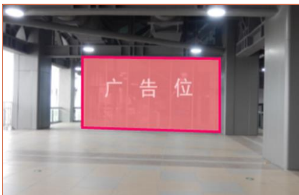
B41 玻璃墙面广告 – 西登录厅
